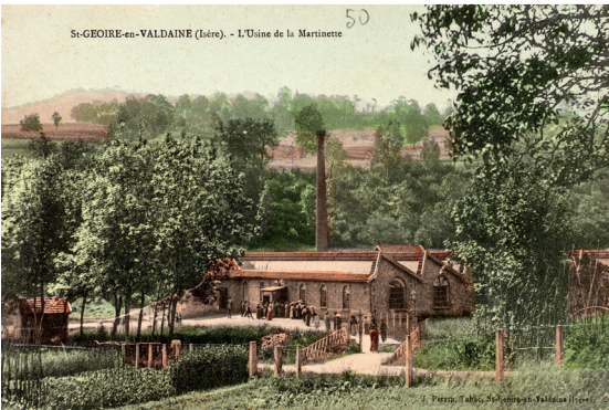
50 St-GEOIRE-en-VALDAINE (Isère) - L'Usine de la Martinette
